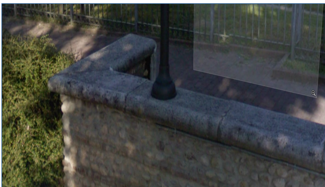
Via Trieste Dante a Limbiate: un particolare del muro
